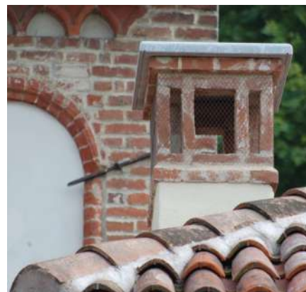
MATTONI, TEGOLE, SUPERFICI MURARIE
